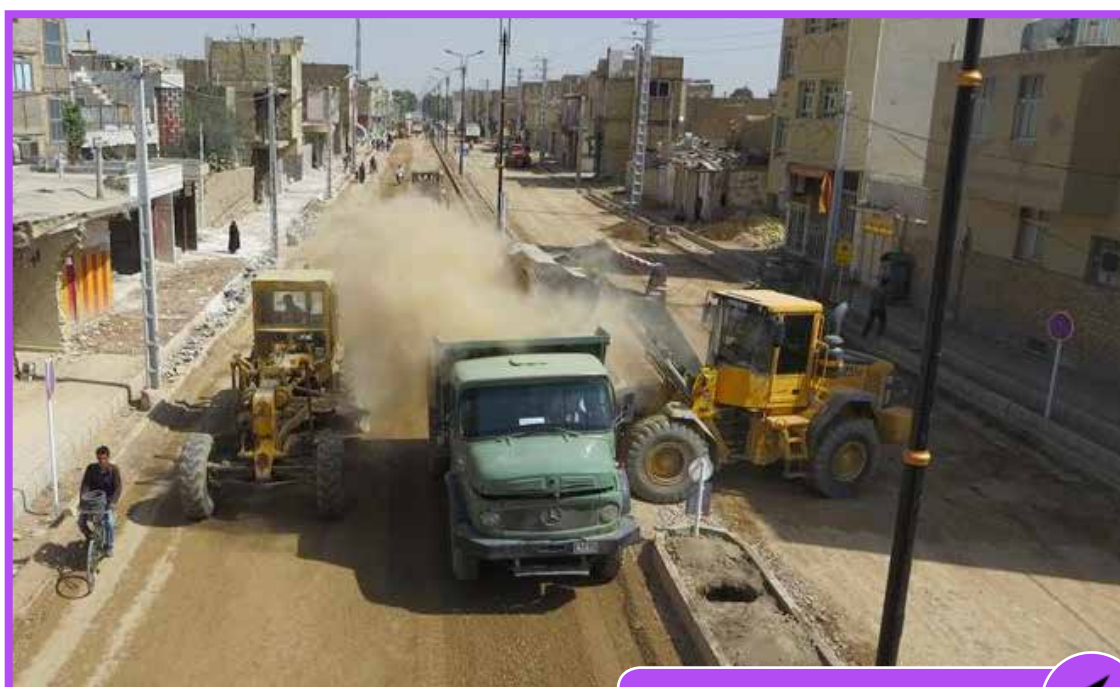
همکاری در احداث بلوار ۱۷ شهرپور
