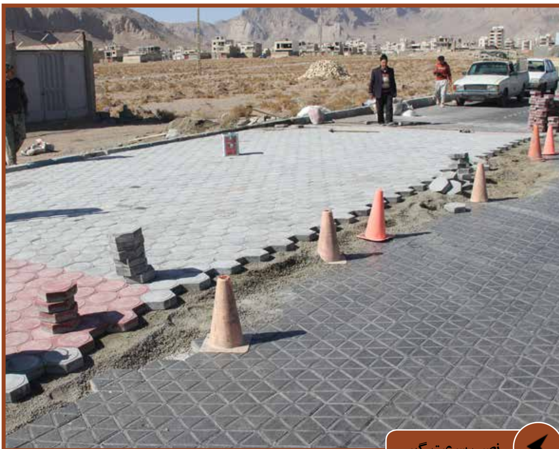
نصب سرعت گیر
