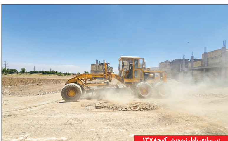
زیر سازی بلوار نبو منش کوچه ۱۳۷
