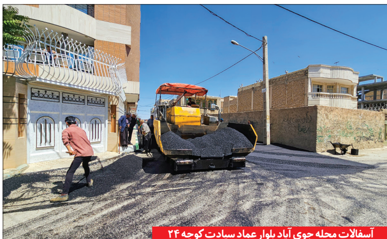
آسفالت محله جوی آباد بلوار عماد سیادت کوچه ۲۴
